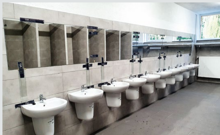
Rekonstrukce umývárny a sprch pro výrobní dělníky
